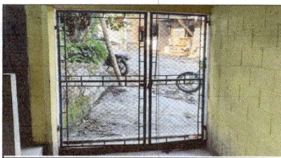
FOTO 12: Fabricación e instalación de portón de metal de ingreso
