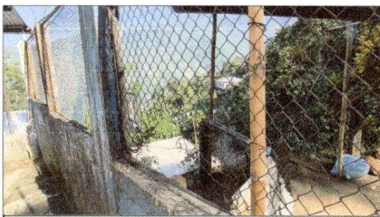
FOTO 11: Reparación de tubo hg y malla galvanizada
