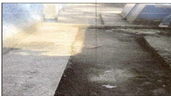
FOTO 10: Reparación de cuneta de concreto
