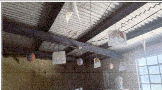
FOTO 8: Sustitución de focos ahorradores
