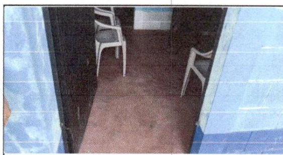
FOTO 6: Sustrucción de piso cerámico
