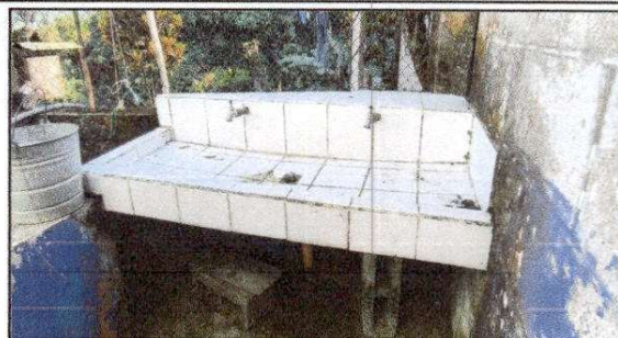
FOTO 2: Sustrucción de Azulejo
