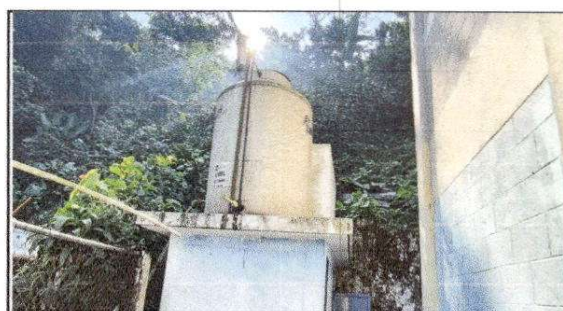
FOTO 4: Sustrucción de depósito de agua 1100 lt
